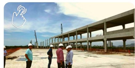
Acompanhando as obras do aeroporto
