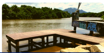
Deck e rampa no ponto final
